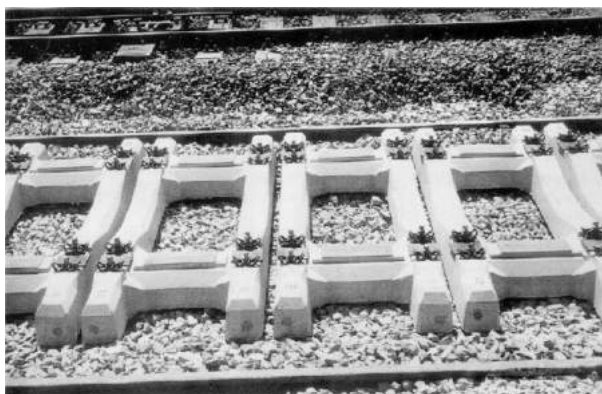
Figura 2. Traversele ramă - vedere de ansamblu
